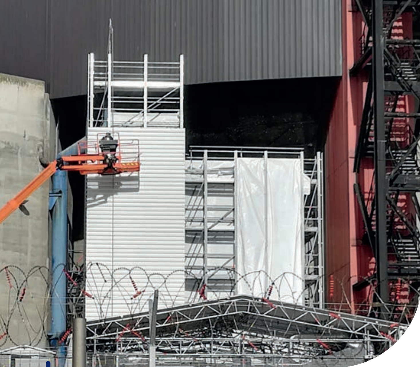
Structure d'accès avec bardage isolant CNPE Flamanville 1&2
