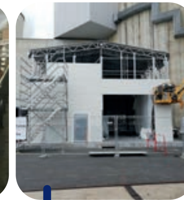
Structure d'accès bardée CNPE Civaux
