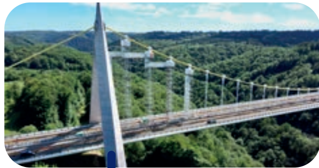
Moyens d'accès et confinement Viaduc de Chavanon
